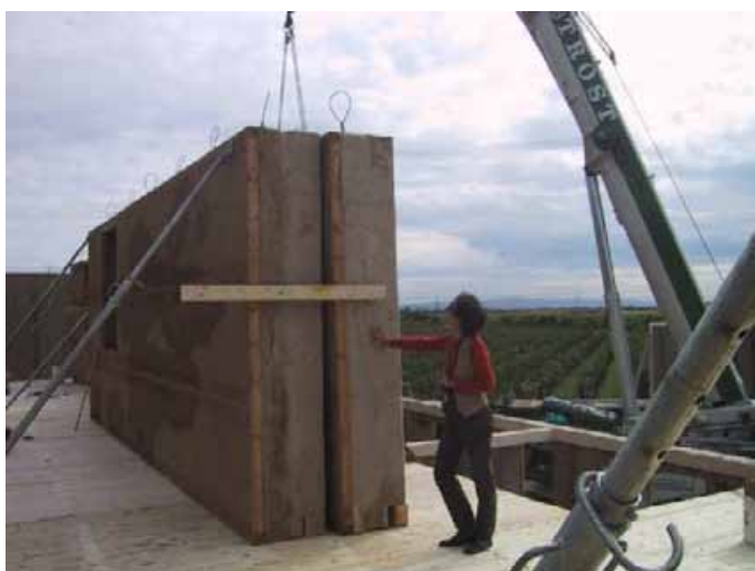
Exemples de murs en pisé préfabriqués en Autriche, Crédit photos : Natur & Lehm
