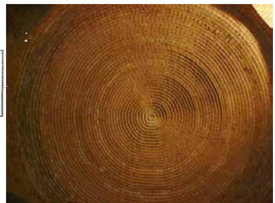
La coupole construite selon la technique de la voûte nubienne
