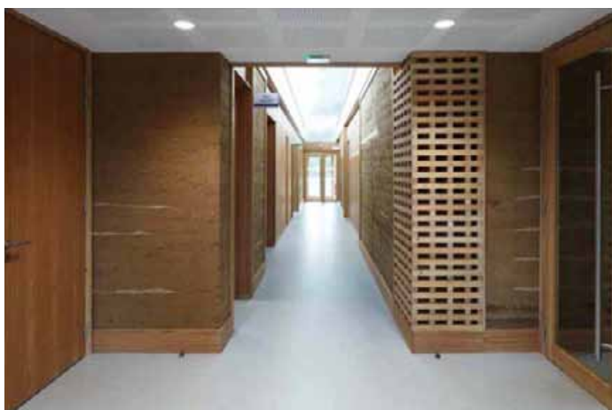
Exemple de murs en pisé préfabriqués en France, Crédit photos : Mil lieux architecte
