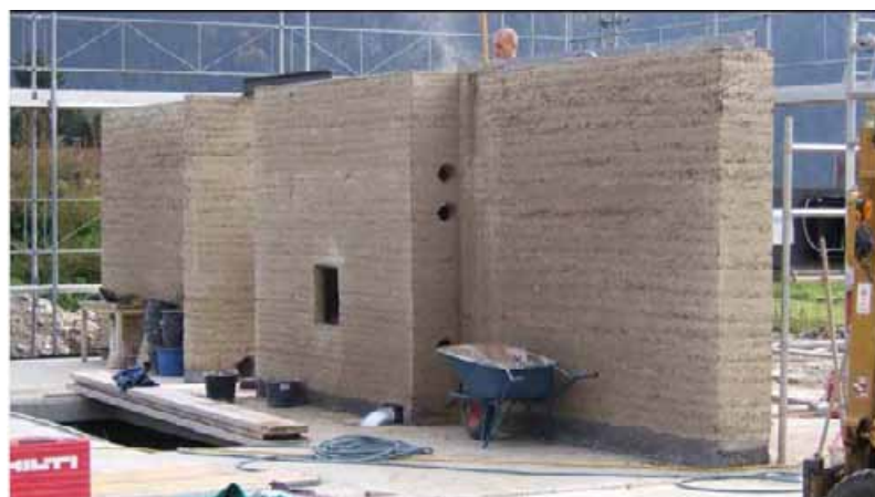
Exemples de murs en pisé préfabriqué en Allemagne et Autriche, Crédit photos : Martin Rauch.
