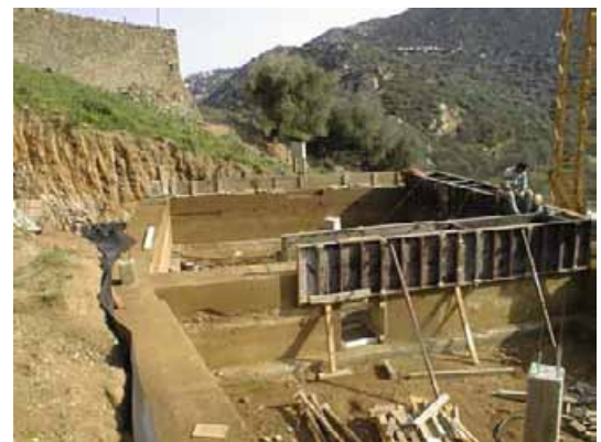
La construction des murs en pisé
